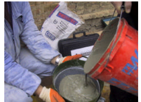
Introduzione della malta nella pompa a pressione attraverso un setaccio
