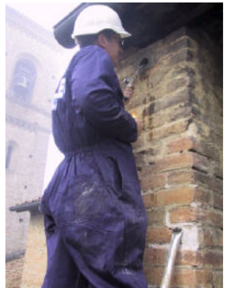
Fase di iniezione in corrispondenza dell'ancora superiore
