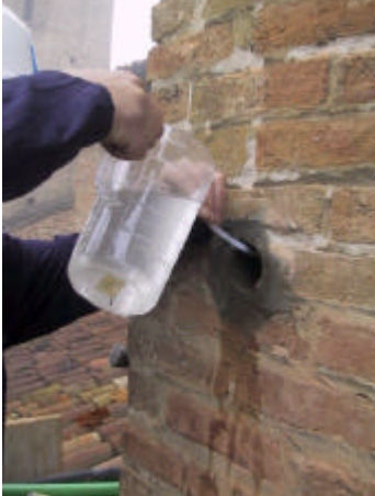
Acqua per inumidire la muratura costituente le pareti del foro (iniezione per colatura o con la pompa)
