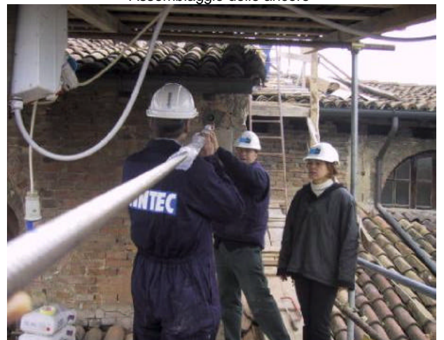
Inserimento delle ancore nei fori
