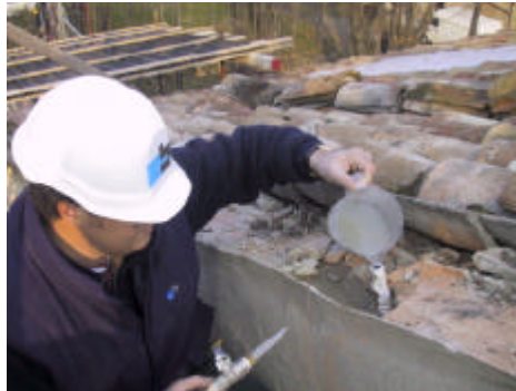
Iniezione di acqua da effettuarsi prima dell'iniezione del materiale consolidante per inumidire le pareti del foro
