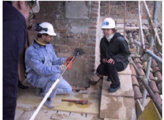
Assemblaggio delle ancore
