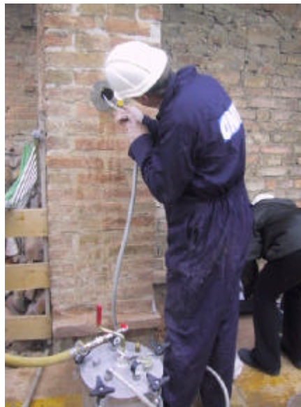
Fase di iniezione in corrispondenza dell'ancora inferiore
