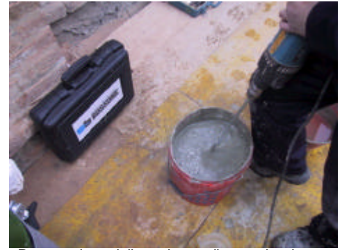
Preparazione della malta mediante miscelatore
