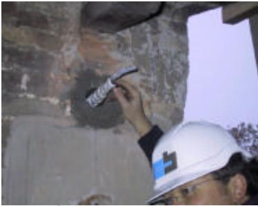
Estremità dell'ancora con particolare dei tubicini per l'iniezione della malta
