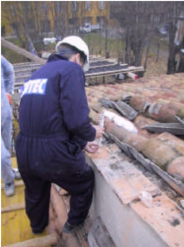
Inserimento delle ancore "CHS" di cucitura
