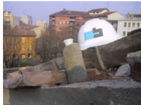
Aspetto dell'ancora ad iniezione eseguita: la formazione di un successivo cordolo in c.a. completerà l'intervento di consolidamento: parte dell'ancora sarà inclusa nel getto con la funzione di collegamento tra le due parti.
