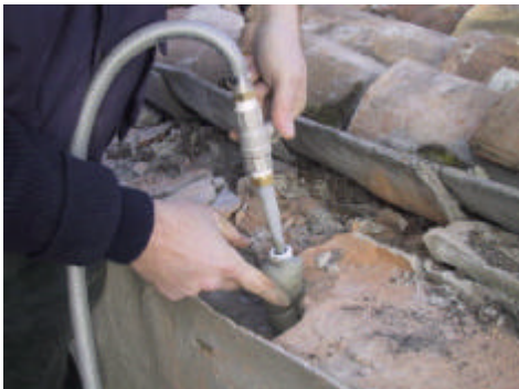
Iniezione della malta fino a completo riempimento della calza
