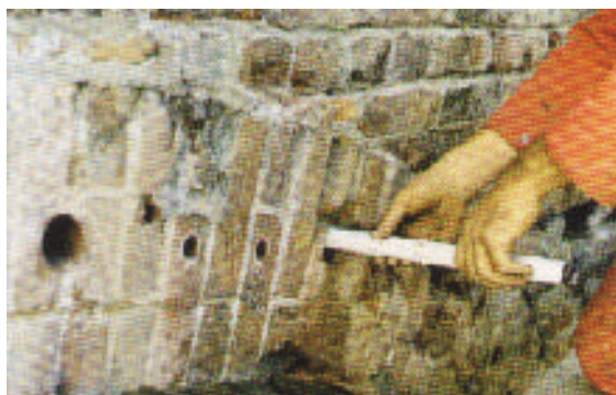
Posizionamento delle ancore nei fori
